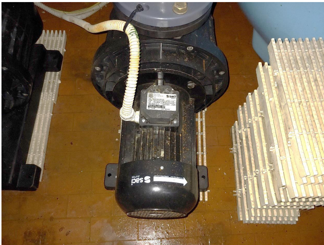
Locale impianti – pompa di ricircolazione
