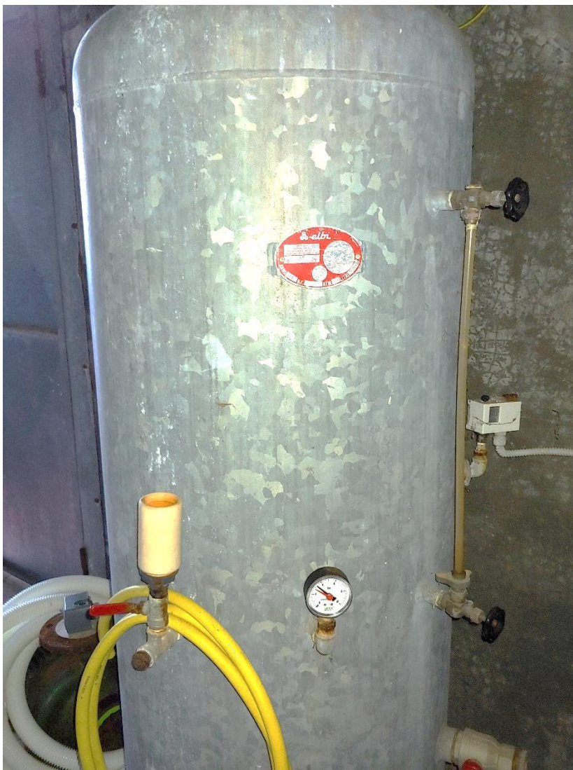
Locale impianti – autoclave acqua sanitaria
