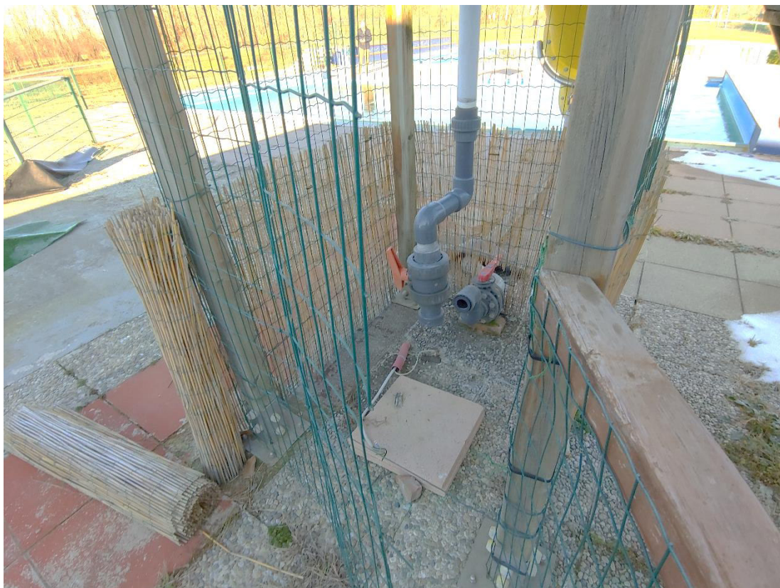
Attacchi pompa di circolazione acquascivolo (la pompa è a magazzino)
