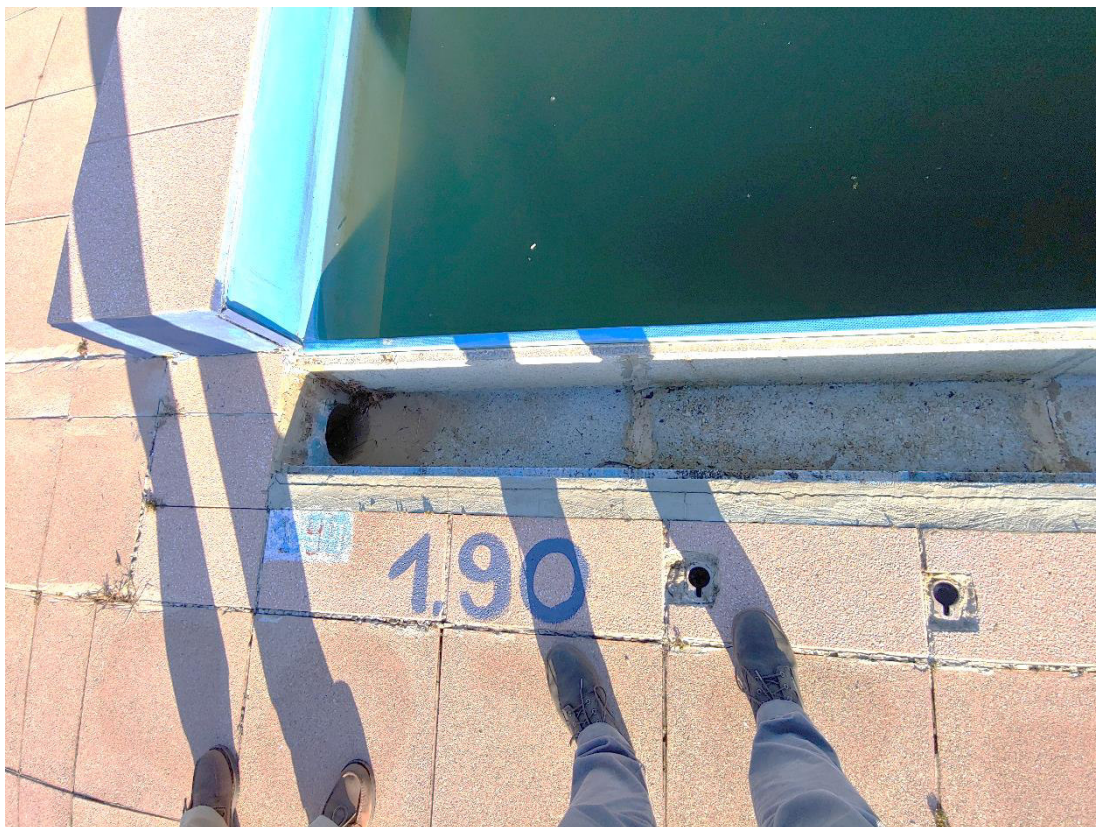
Particolare termine canale bordo sfioro – inizio tubazione di scarico nella vasca di compenso
