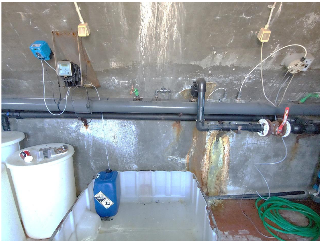
Locale impianti – parete est – piping – pompa dosatrice cloro
